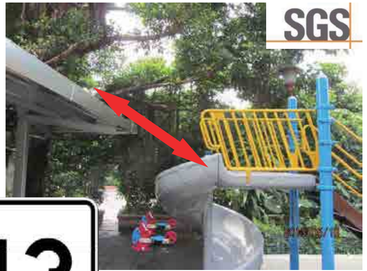
圖 A.58 架高之障礙物圖例(參照 9.8.4)
