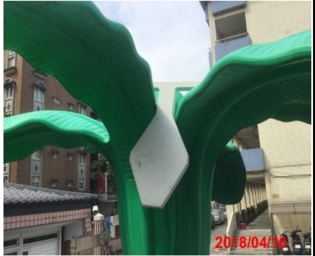
樹木造形裝飾物上葉子間的凹陷空隙，均構成不當頸部誘陷的缺失。
