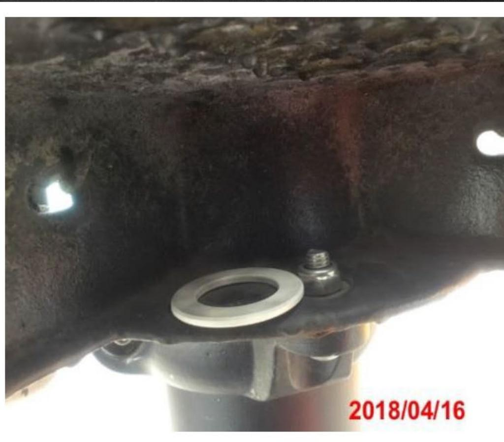
平台底部的可觸及六角螺帽構成平面型的突出物，均構成纏結危險物。
