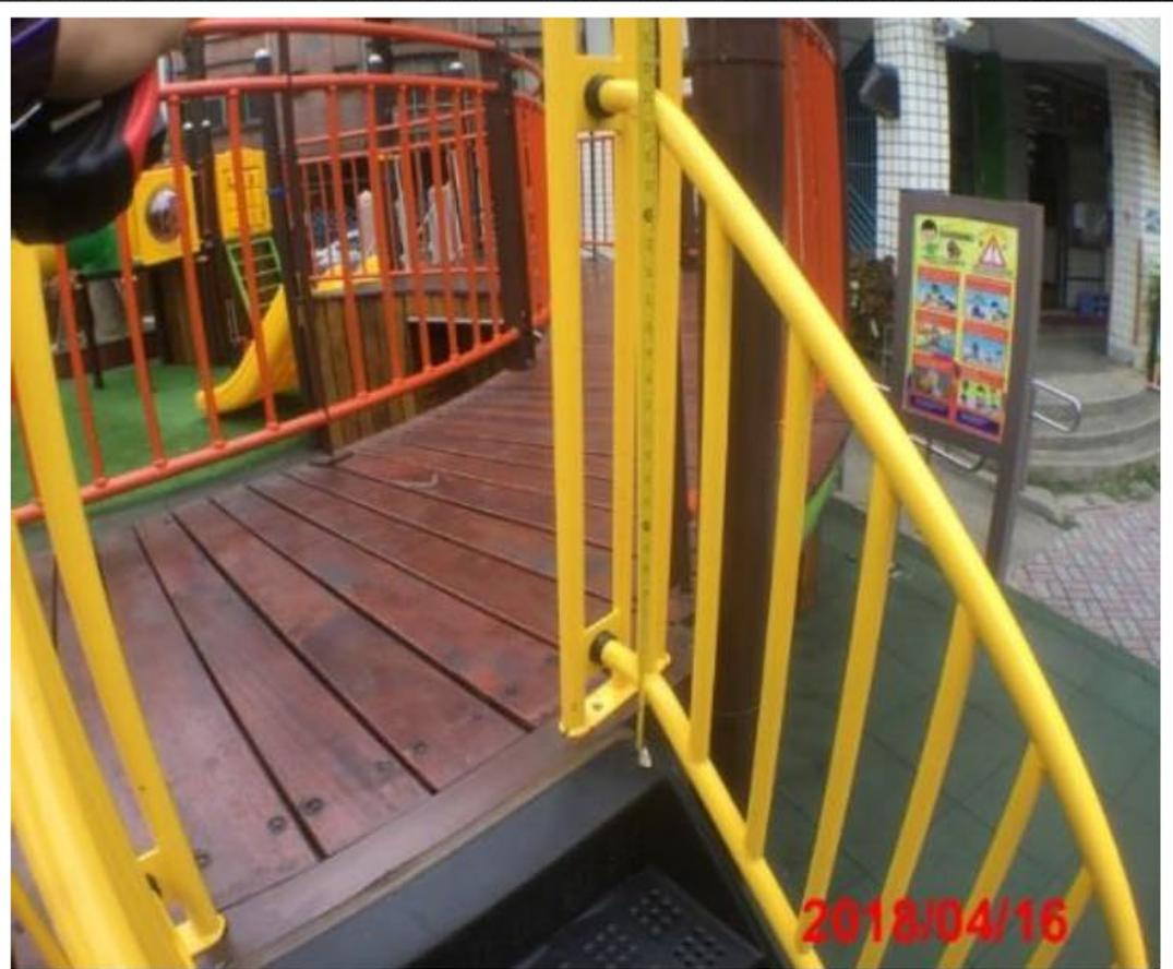
階梯最上方一階的踏面離地高度已超過122cm，護欄上緣距離踏面的高度不及至少97cm，實際量測僅約69/73cm。
