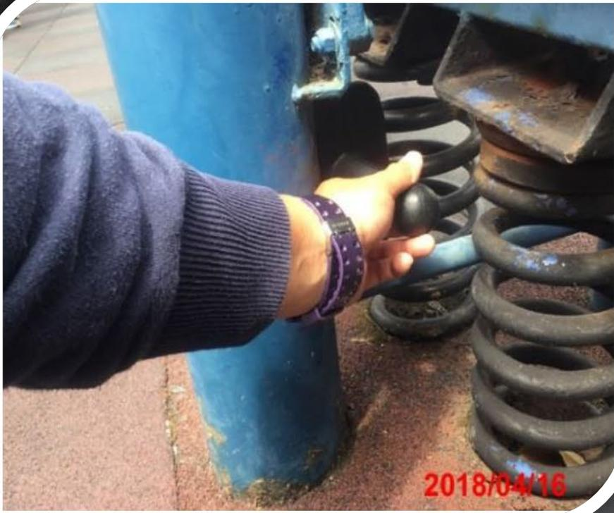
蹺蹺板的腳踏板寬度，均小於至少8.9cm的要求。實際量測約7.9~8.2cm。
