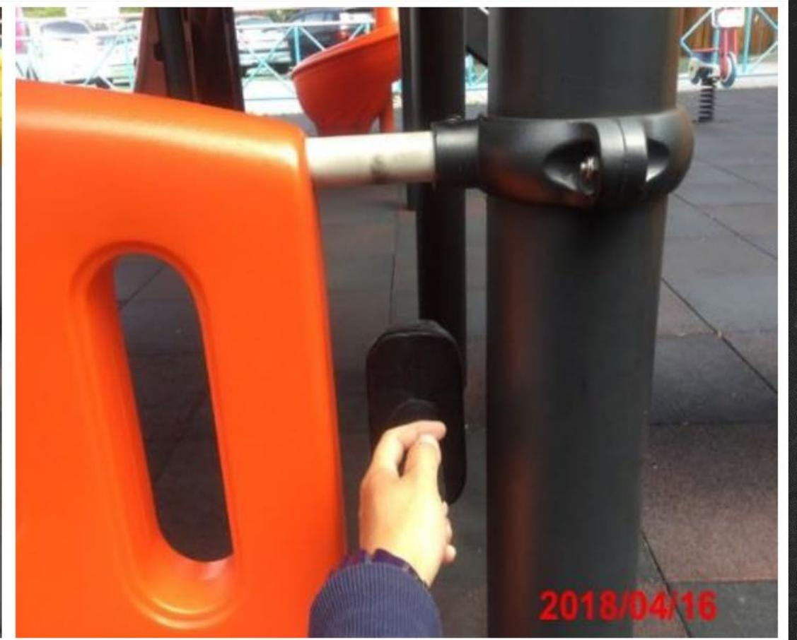
遊戲板與支柱間的空隙，右側位置構成不當頭部誘陷的缺失。
