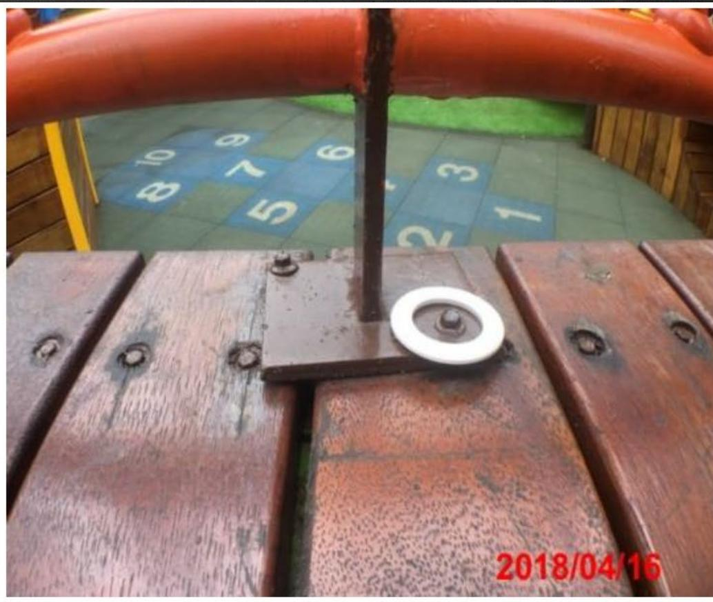
組合遊具護欄上的固定六角形螺栓的端點形成「平面型」的突出物，均構成纏結危險物。
