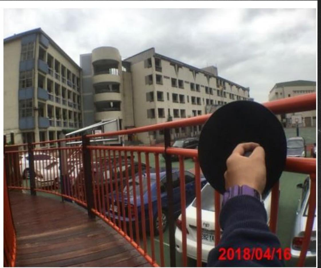
護欄上方的空隙，均構成不當頭部誘陷的缺失。
