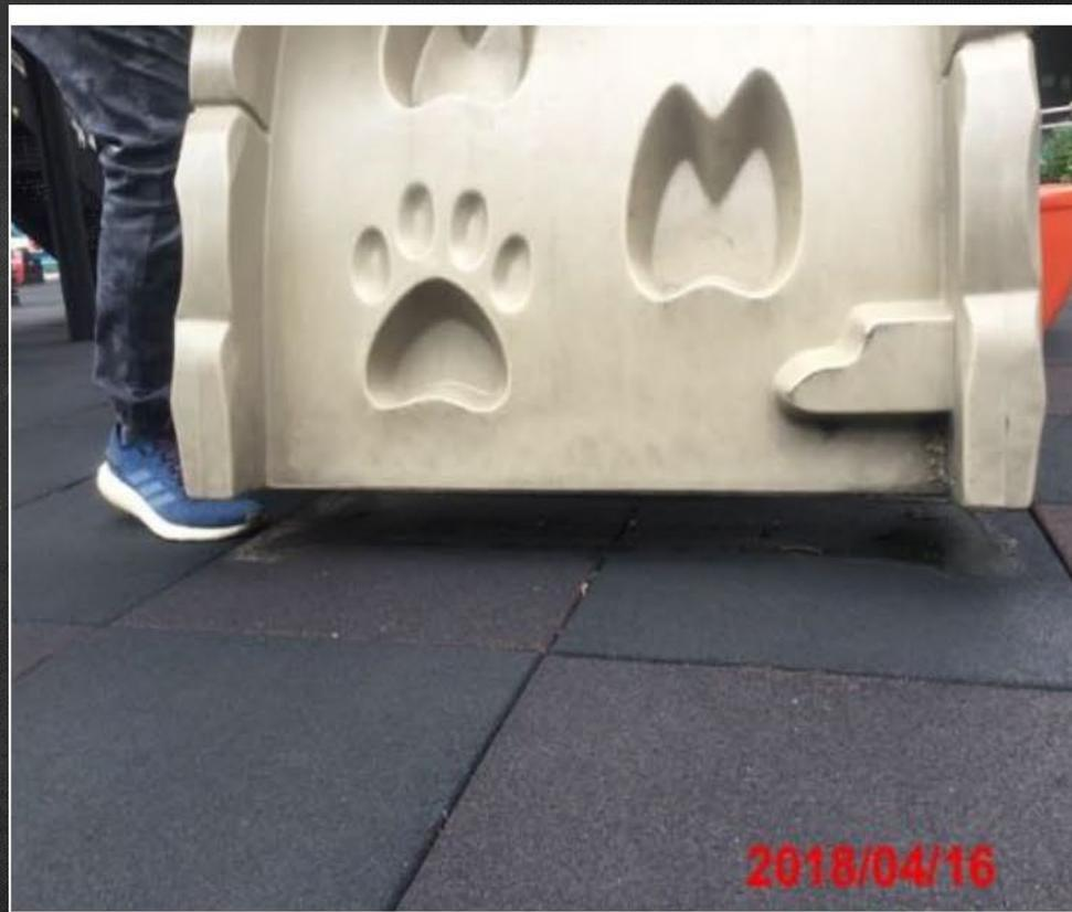
拱型攀爬架底部的位置沒有確實安裝固定於地面。
