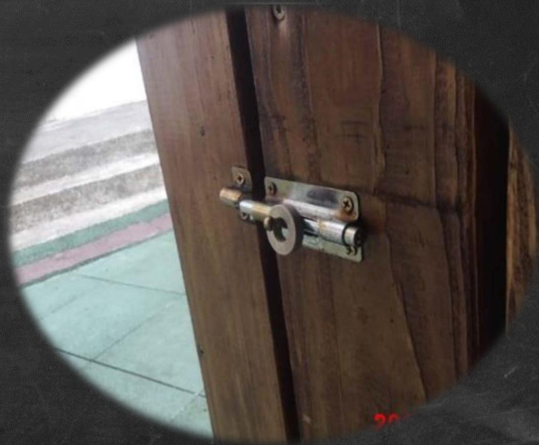
組合遊具下方門栓端點過度突出，構成不當的突出點。
