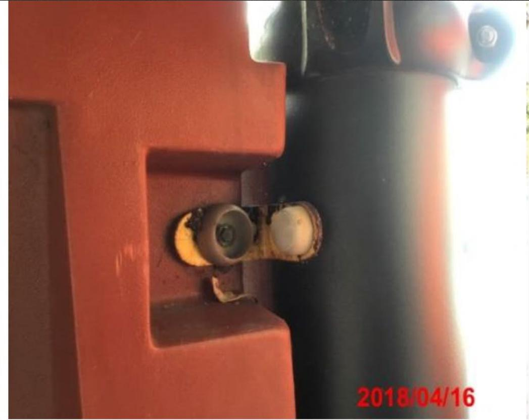
平台底下遊戲板的螺栓塑膠帽蓋，多處出現明顯破損的現象。
