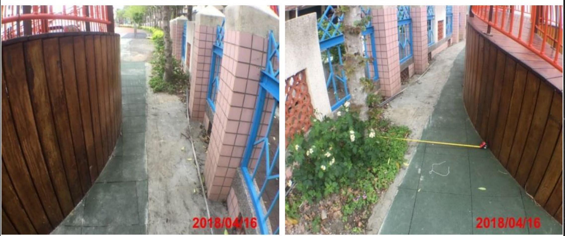
組合遊具在至少183cm的使用區域內出現大型樹幹的障礙物，且使用區域內出現硬質的混凝土（水泥）的地面，不符合要求。
