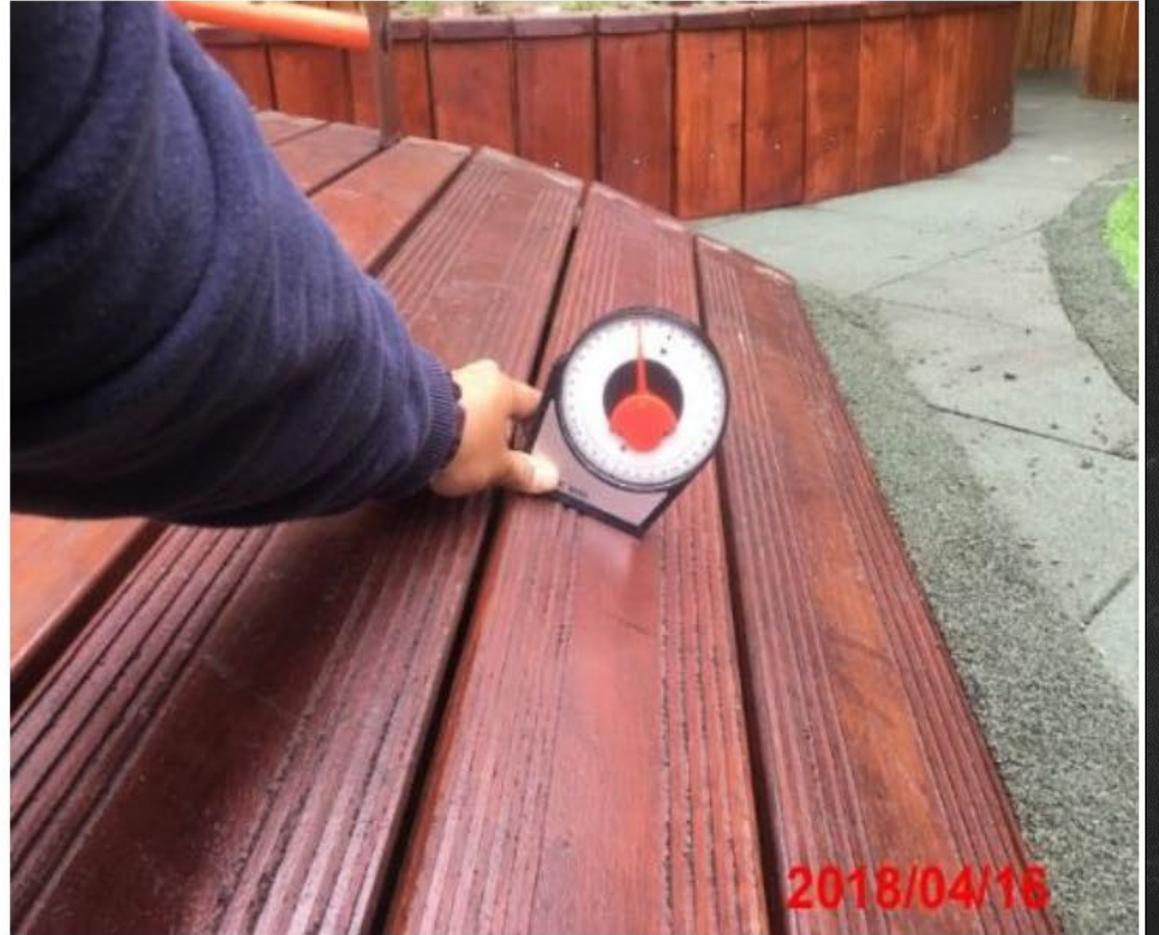
坡道的垂直距離：水平距離沒有大於1：8 (大約7°)，實際測量約25°，不符合要求。
