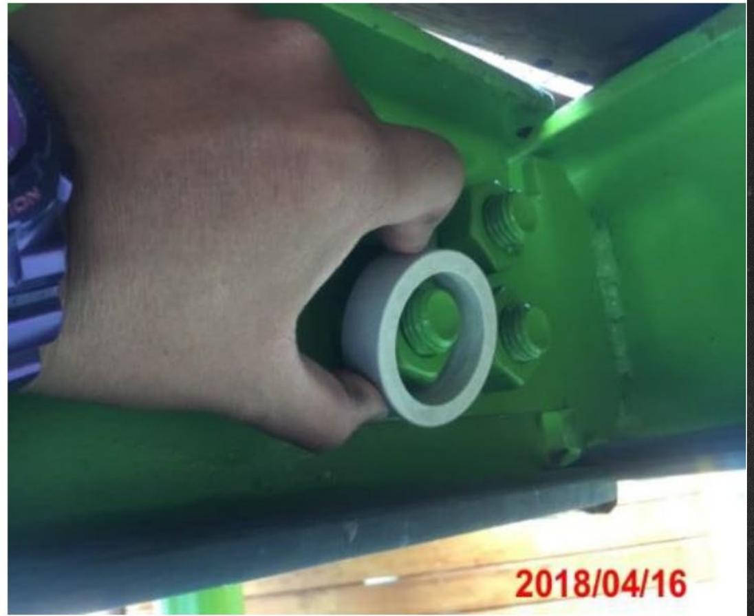
組合遊具平台底部的固定螺栓端點超出螺帽面2個螺紋以上，構成纏結危險物；且螺栓端點過度突出，構成不當的突出點。
