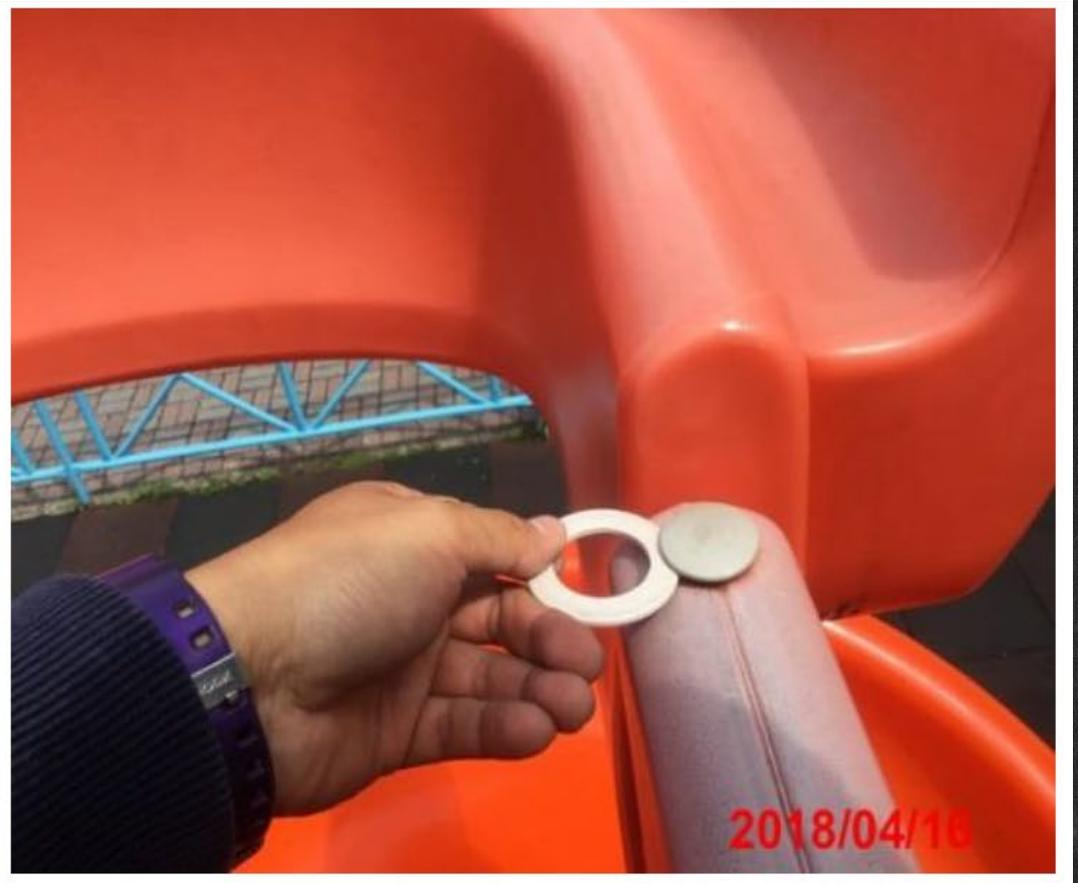
螺旋滑梯上方護欄的螺栓護蓋與護欄沒有密合，形成增大型突出物，屬於纏結危險物。
