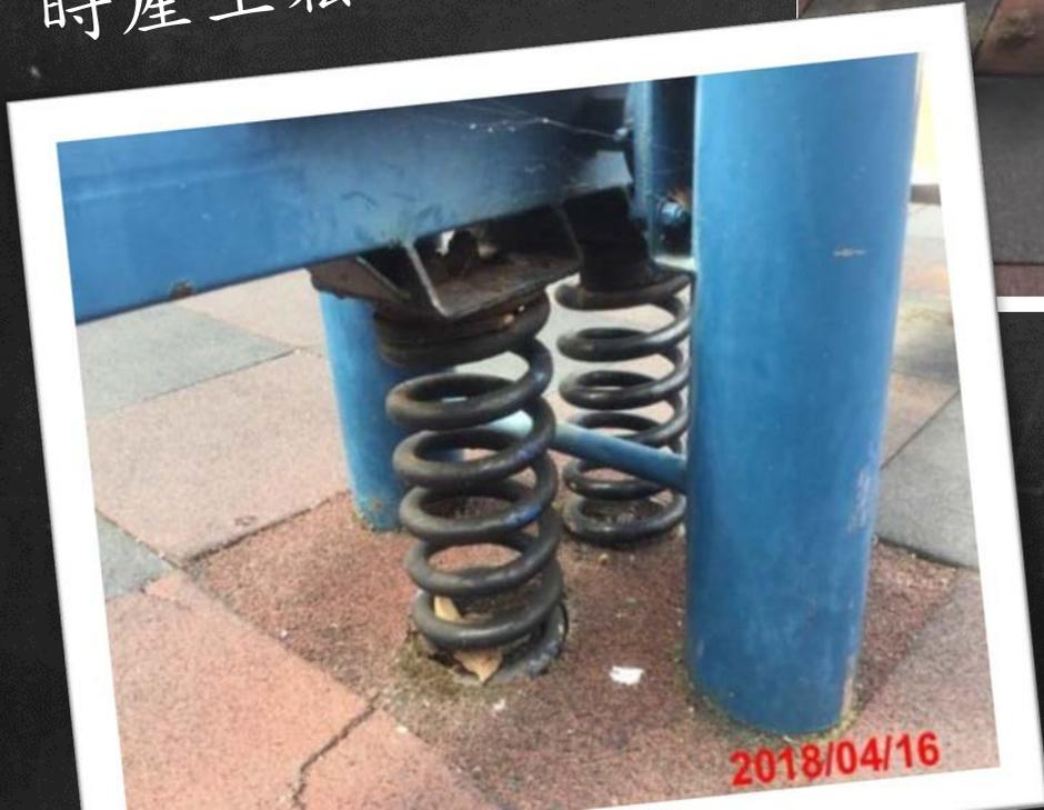
跷跷板下方固定踏板的金屬材料表面，出現鏽蝕的現象。
