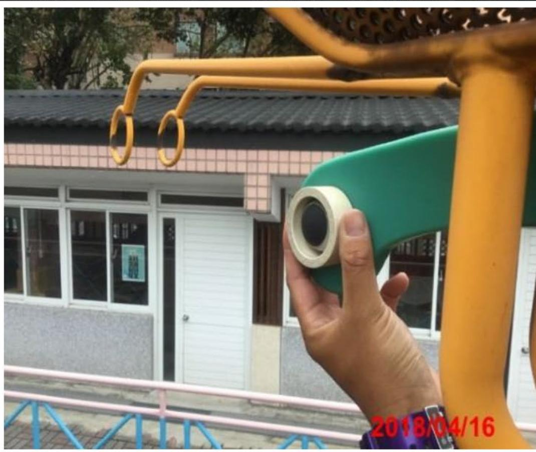
蝴蝶造形裝飾物上固定螺栓的塑膠帽蓋端點過度突出，多處構成不當的突出點。
