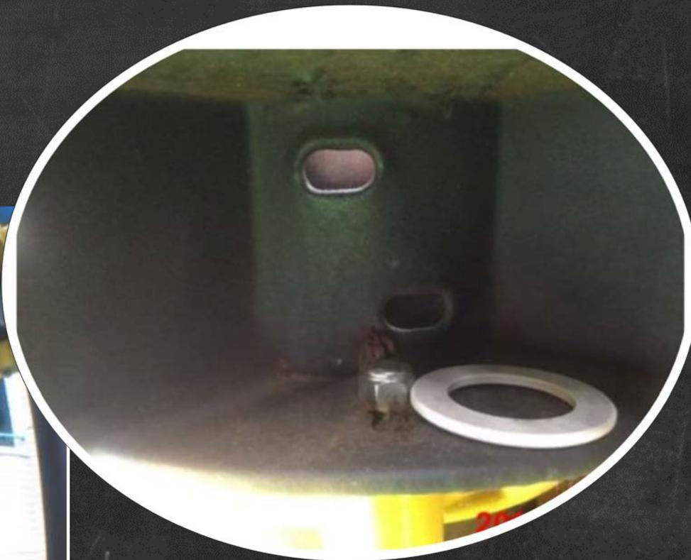
組合遊具平台底部的固定六角形螺栓的端點形成「平面型」的突出物，均構成纏結危險物。
