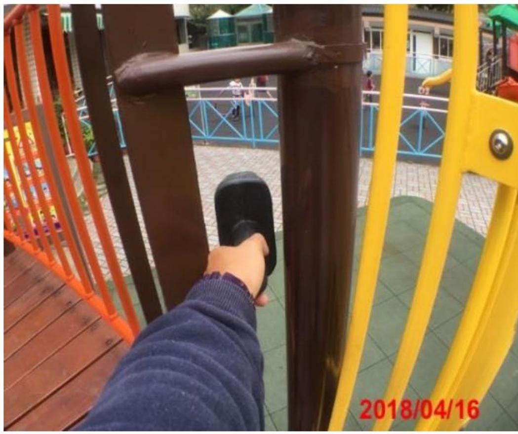
階梯上方護欄的支柱與支柱之間的空隙，均構成不當頭部誘陷的缺失。
