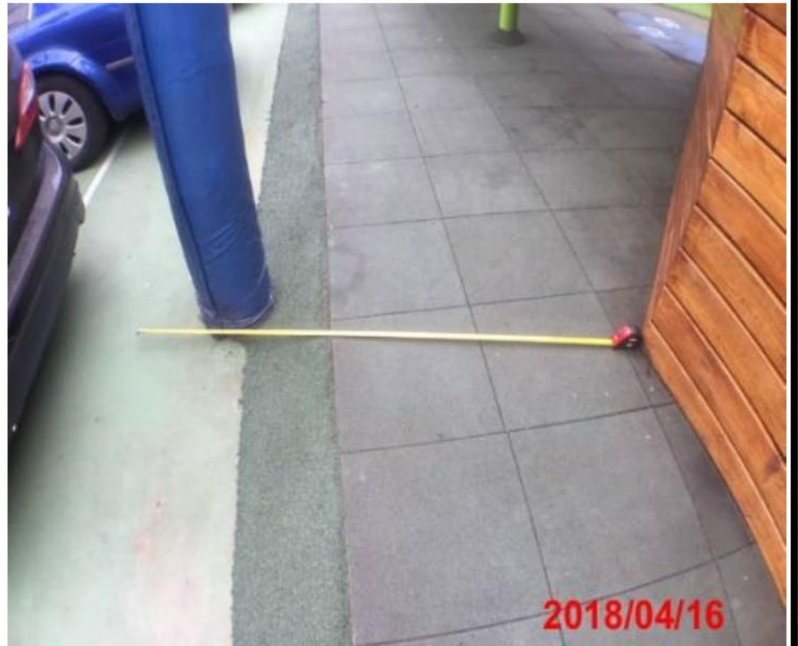
組合遊具在至少183cm的使用區域內出現大型籃球架的障礙物，且使用區域內場地高低落差的現象及硬質的混凝土（水泥）地面，均不符合要求。
