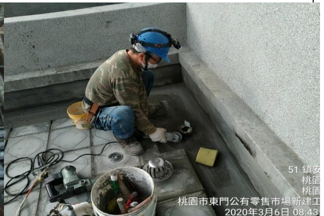
圖 9.4：以水泥砂漿當集水溝表面材料
