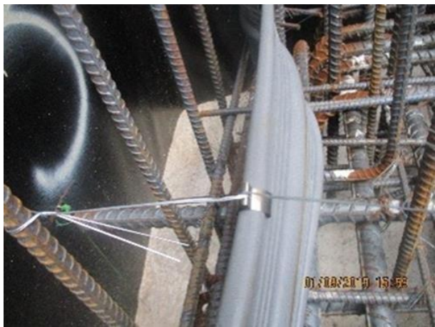
圖1.3：止水帶安裝固定
