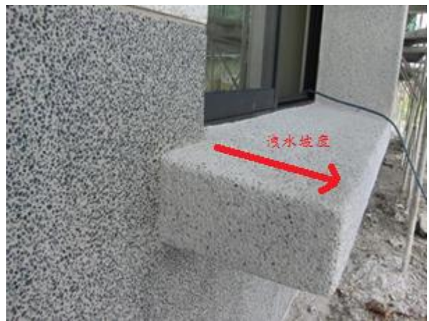
圖 6.8：窗台向外傾斜以利排水
