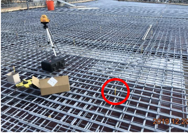
圖 9.1：結構體灌漿前以標高器抓洩水坡度 1/200
