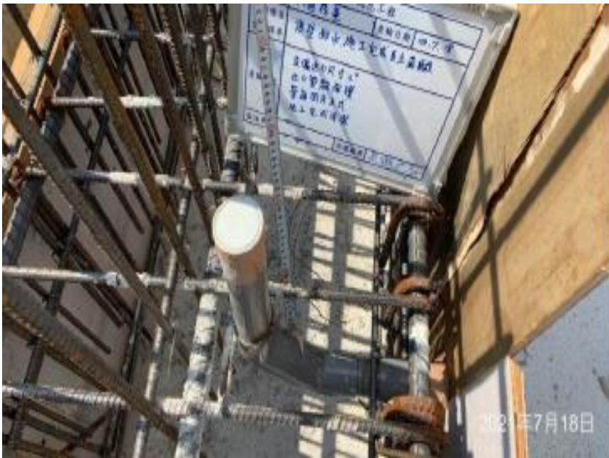
說明 4： 複壁排水管線施 作
