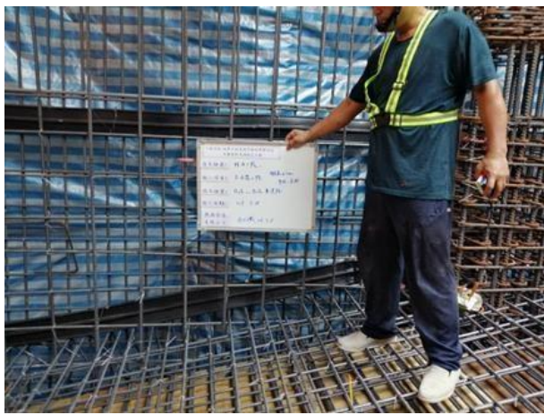
圖 2.8：外牆分次澆築須設止水帶
