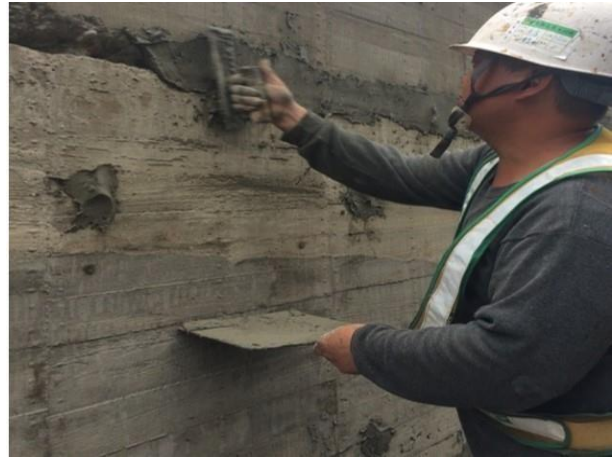
圖 7.2：水泥砂漿填補
