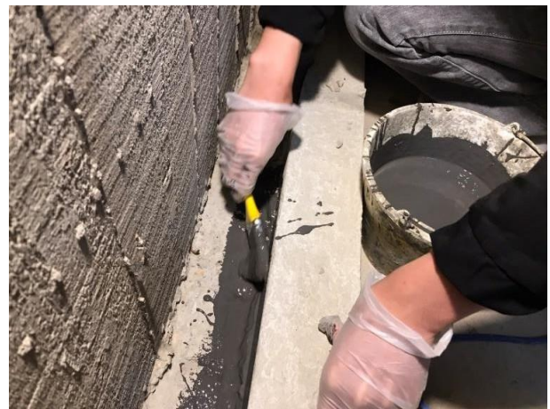
圖 3.4：先 1:2 防水粉刷後再塗防水膠
