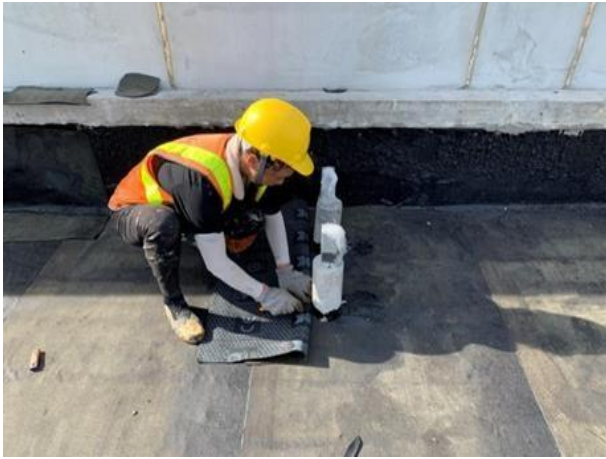
圖 10.5：穿板管開口補強
