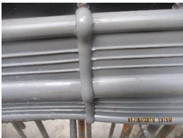
圖1.5：止水帶熱熔對接
