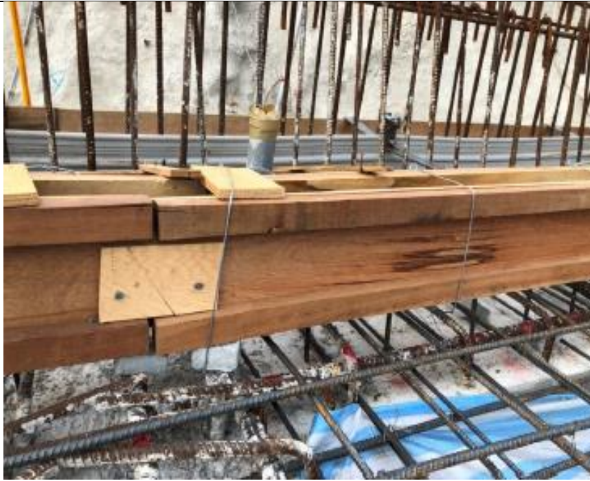
說明 3： 止水墩模板，吊 模施作
