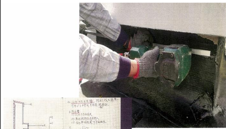
搭接封膠(含壁體 L 型鋁製壓條)
