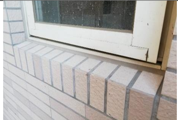
圖 6.4：磁磚黏貼方向與排水方向一致
