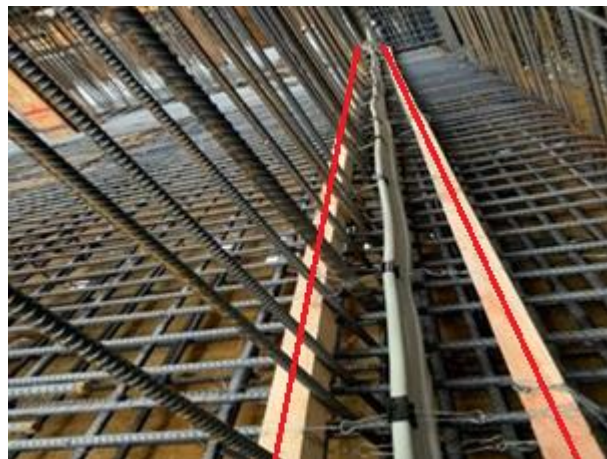
圖 1.2：凸 key 角材二支置於牆筋二側
