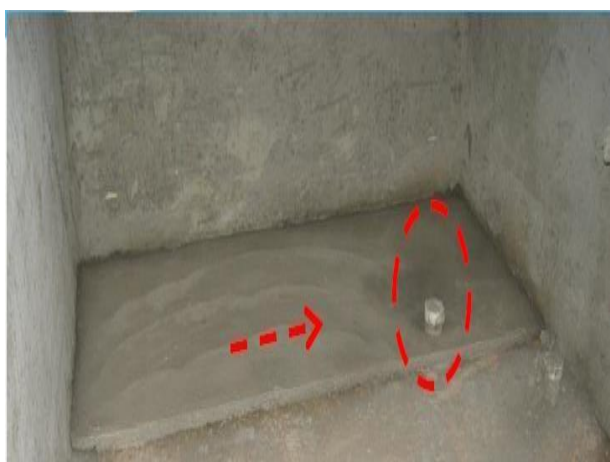
圖 5.1：浴缸底加高，並做洩水坡度
