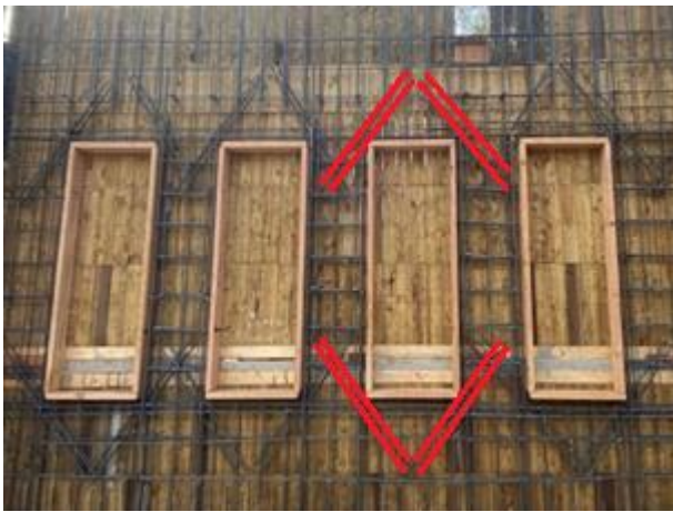
圖 6.5：窗框周遭補強筋綁紮
