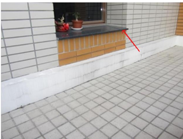
圖 6.7：窗台設置批水板以利排水
