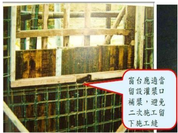
圖 6.6：窗台模板應留設灌漿口
