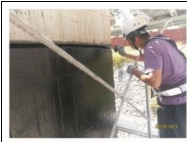
圖 2.4：防水收頭施作
