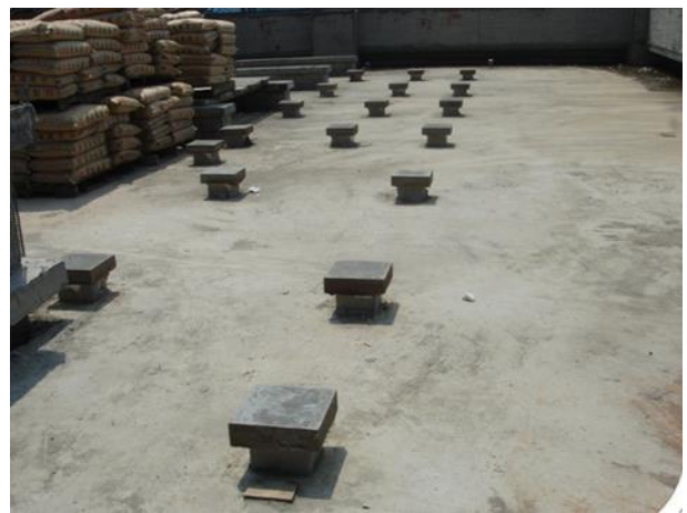
圖 10.10：設備基礎座設置泛水
