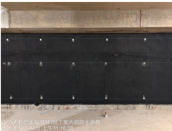
圖 3.5：確認連續壁已止水
