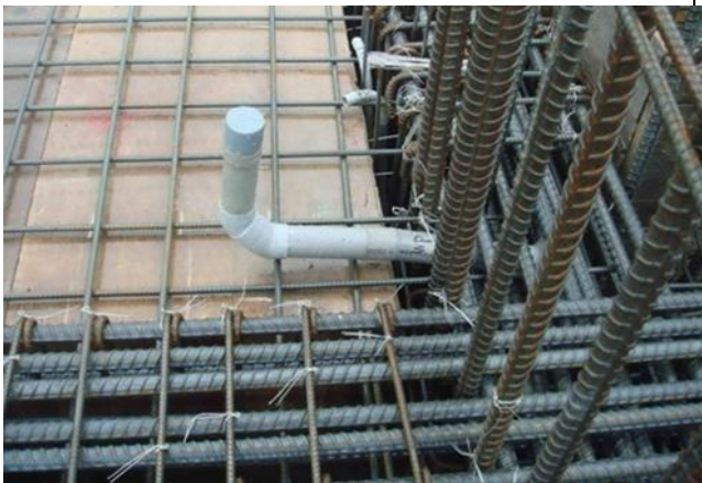
圖 9.1：結構體灌漿前以標高器抓洩水坡度 1/200
