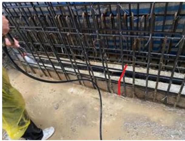
圖 2.9：預留凸 KEY、預埋止水帶
