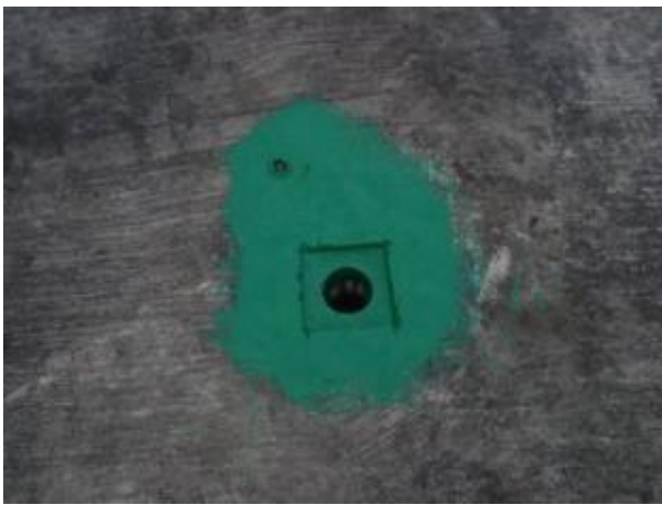
圖 10.7：落水管處防水補強
