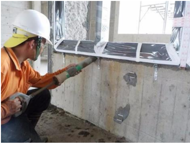
圖 6.1：嵌縫確實填滿框與結構體縫。
