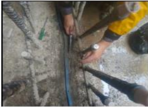
無收縮混凝土填縫
