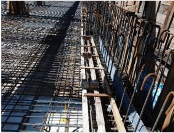
圖 3.1：複壁止水墩與版一次澆築
