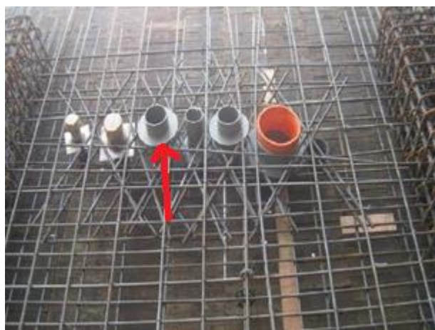
圖 2.7：穿牆管須有止水環
