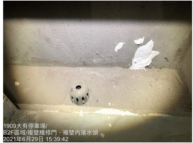
圖 3.2：落水頭留於排水溝中最低處
