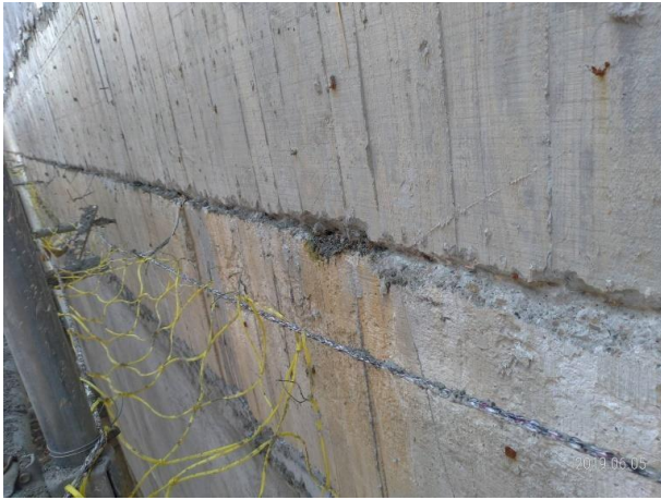
圖7.1：接縫處打V型槽，清除雜物
