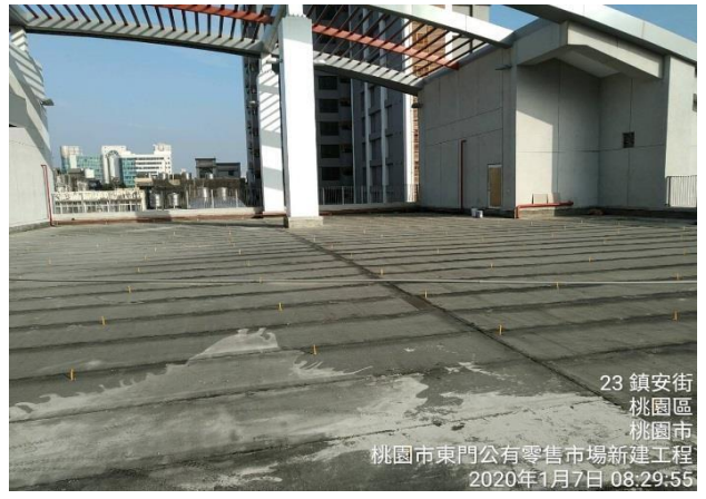
圖 9.2：防水層施作後，以標高器控制 1/200 洩水坡度
