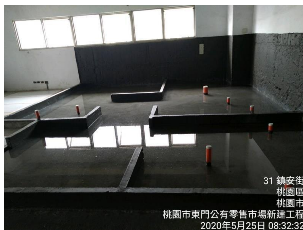
圖 5.6：試水作業
