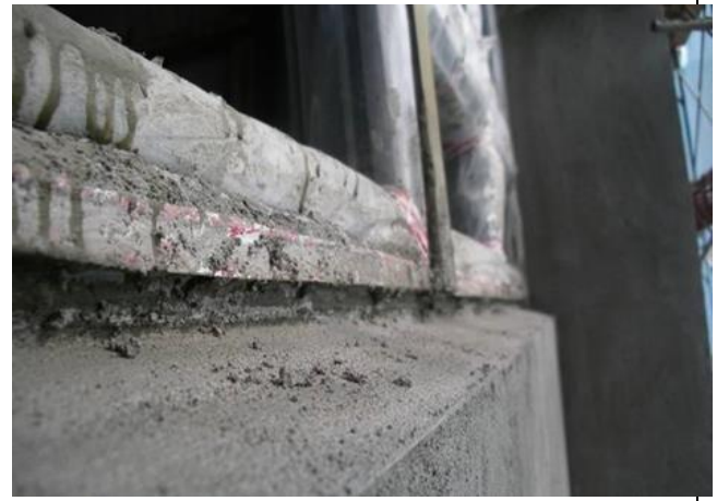
圖 6.2：窗框底緣抓洩水坡度粉刷
