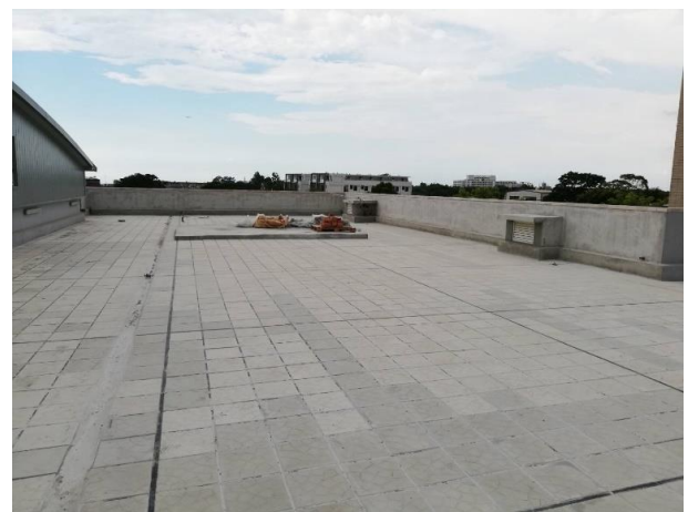
圖 10.4：隔熱磚設置伸縮縫
