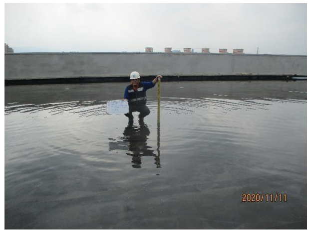
圖 10.8：試水作業
