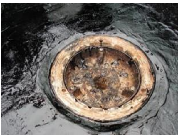
圖8.1：落水頭擴口以利防水層折入
