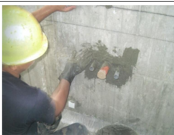
圖 2.5：穿牆管四周以防水材補強
