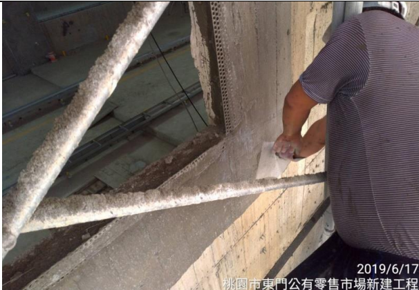
圖 6.3：窗框角隅施作防水抗裂網
