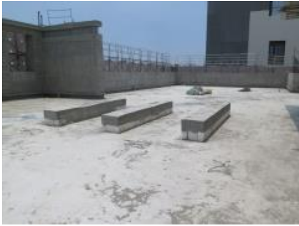
圖 10.11:設備基座泛水
