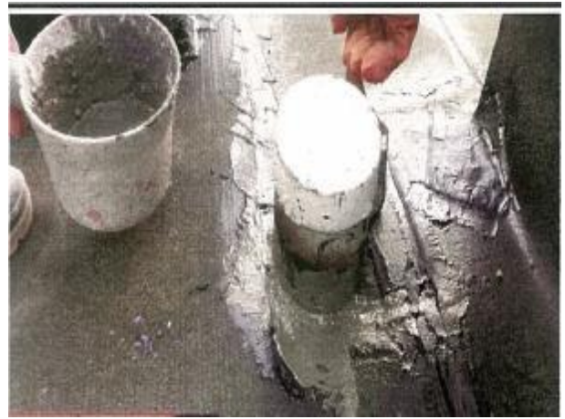
圖 10.6：落水管處防水補強
