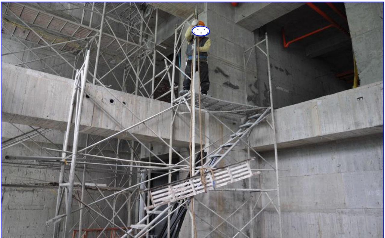
照片 13：施工架拆除作業，使用繩索並以立架為支點，以人力吊運整捆構材（例如立架、交叉拉桿及下拉桿等），因作業勞工無防墜設施，且立架及腳柱接頭無法承受吊掛重量，易造成腳柱接頭彎折斷裂、人員墜落及吊掛物飛落等災害，該搬運方法如未經專任工程人員確認安全性者，應予避免。
